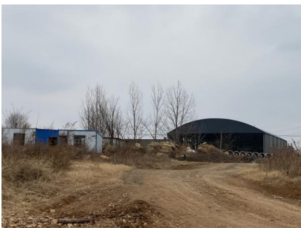
项目东侧制管厂
